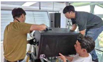
다목적실 음향장치 보수공사(10.20)
