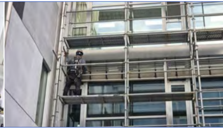
외부 베네시안 블라인드 보수(10.20)
